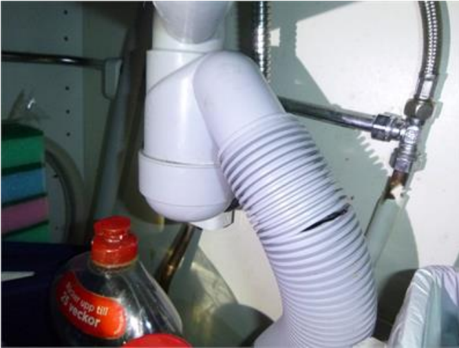
Trasigt avlopp i diskbänkskåpet
